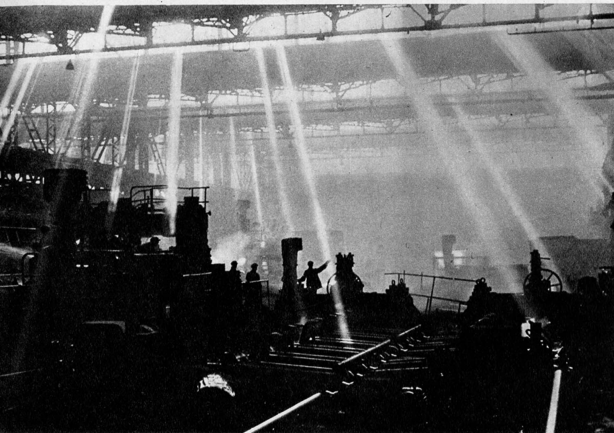
На трубопрокатном заводе
